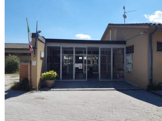
Punto di ingresso
